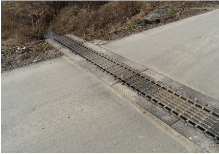
Zdjęcie 45. Przepust dla płazów – korytkowy otwarty, pod lokalną drogą
