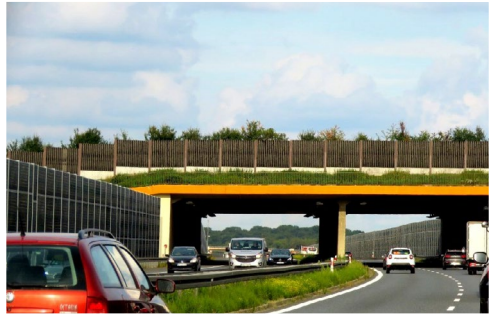
Zdjęcie 46. Przejście górne nad autostradą dla dużych zwierząt
